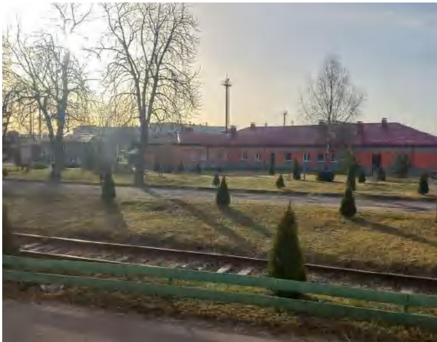
Рисунок 8 – Вид на лесопильный корпус с административно-бытовыми помещениями
