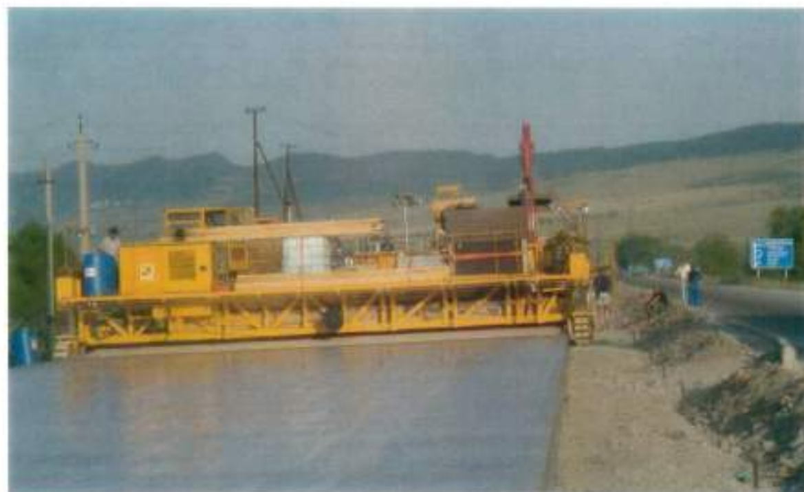
Рисунок 7.7 – Укладка бетонной смеси с помощью дорожного бетоноукладчика
