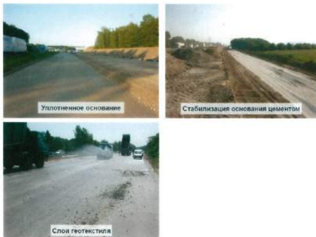
Рисунок 7.6 – Подготовка основания для устройства бетонного покрытия
