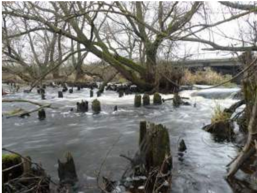
Рисунок 2.9.20 – Остатки деревянных свай от моста и мельницы на р.Сха Фото В.И.Кошмана
