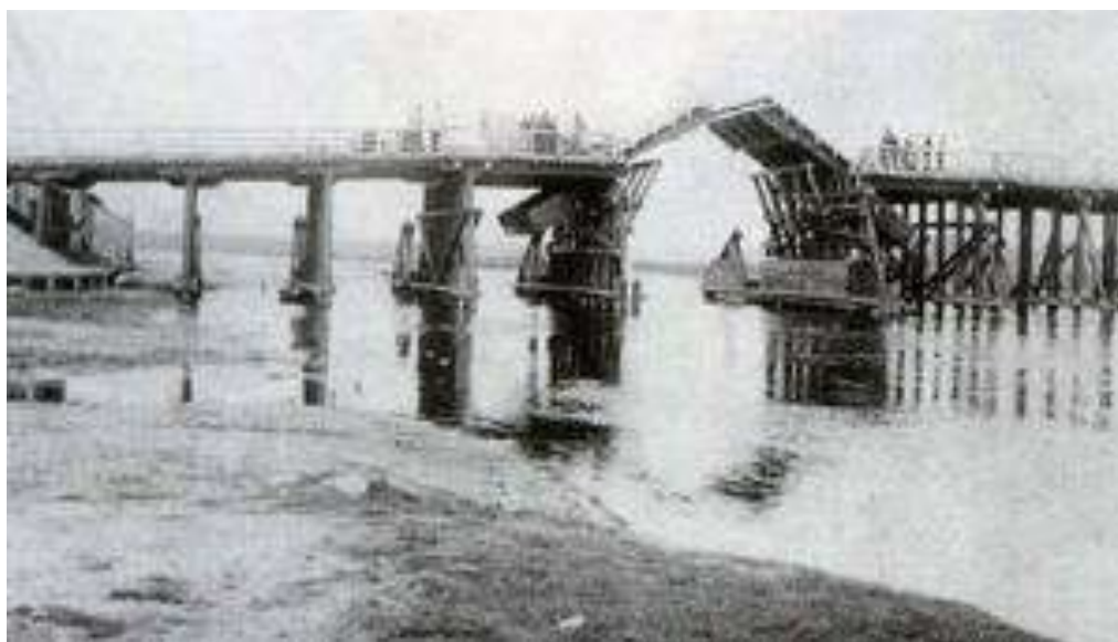
Рисунок 2.9.15 – Мост через Березину в Борисове, который раздвигался для прохождения пароходов (фото начала XX в.). Длина – 554 метра.
